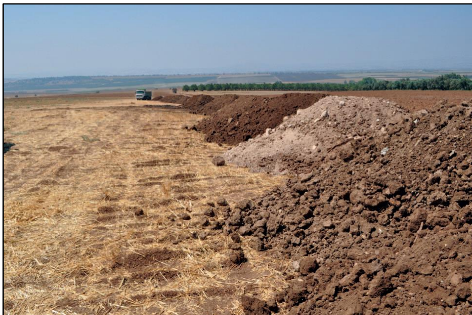
איור 4: פיזור קרקע מעודפי כריית תוואי מסילת רכבת העמק בשטחים שהקרקע נסחפה בהם עד כדי חשיפת התשתית הסלעית. צילום: רמי זיידנברג
